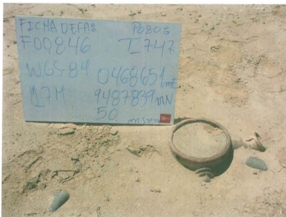
Fotografía N° 1. Pozo T_747, presenta casing abierto pero cubierto de arena.
