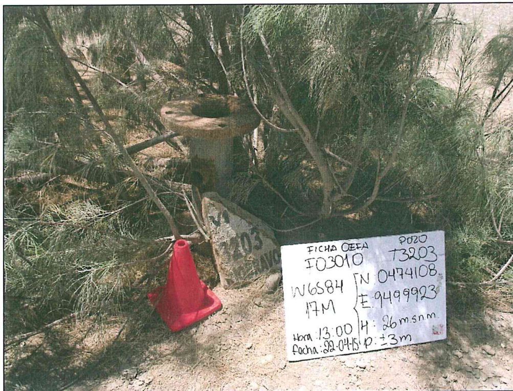
Fotografía N° 1. Ubicación del pozo inactivo, con casing de superficie de 10 plgs de diámetro y 1 m de altura sobre el nivel del suelo, además, el casing presenta 2 tuberías laterales sin válvulas que aseguren su hermetismo.
