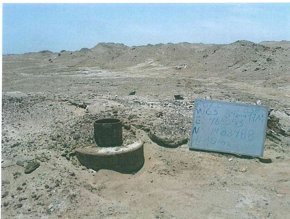
Fotografía N° 1. Pozo inactivo con código PERUPETRO T_838 donde se observa el casing, abierto y expuesto al ambiente.
