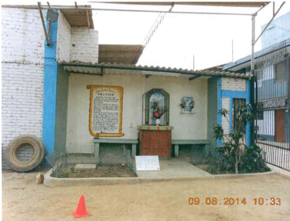
Fotografía N° 3. El pozo estaría ubicado por debajo de la losa de concreto ubicada cerca a la gruta
