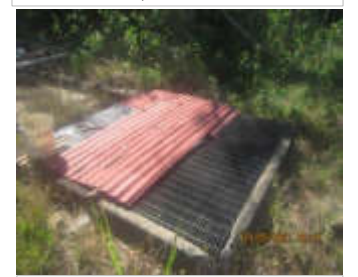
Vista donde se aprecia Pump Tank de concreto, con una cubierta semibierta de calamina y rejilla metálicas, está asociado a los pozos DORI-10 y DORI-11.
