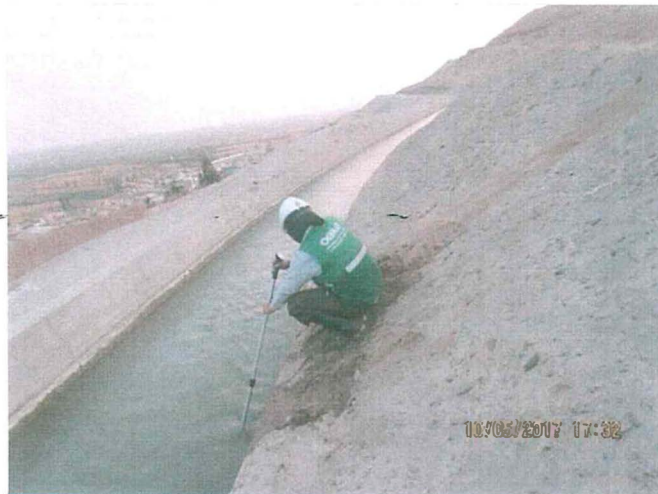
Fotografía 10-3. Canal de riego Ensenada Mejía-Mollendo (CAEMM-04)
