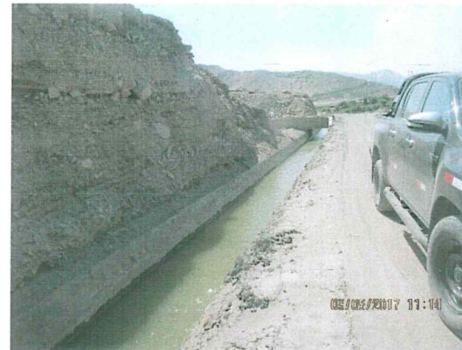
Fotografía 10-2. Canal de riego Ensenada Mejía-Mollendo (CAEMM-02)
