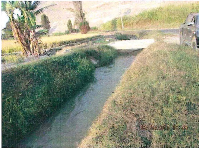
Fotografía 10-5. Canal de riego Punta de Bombón (CAPB-01)
