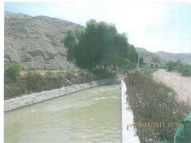
Fotografía 10-4. Canal de riego del Valle de Tambo (CAT-01)
