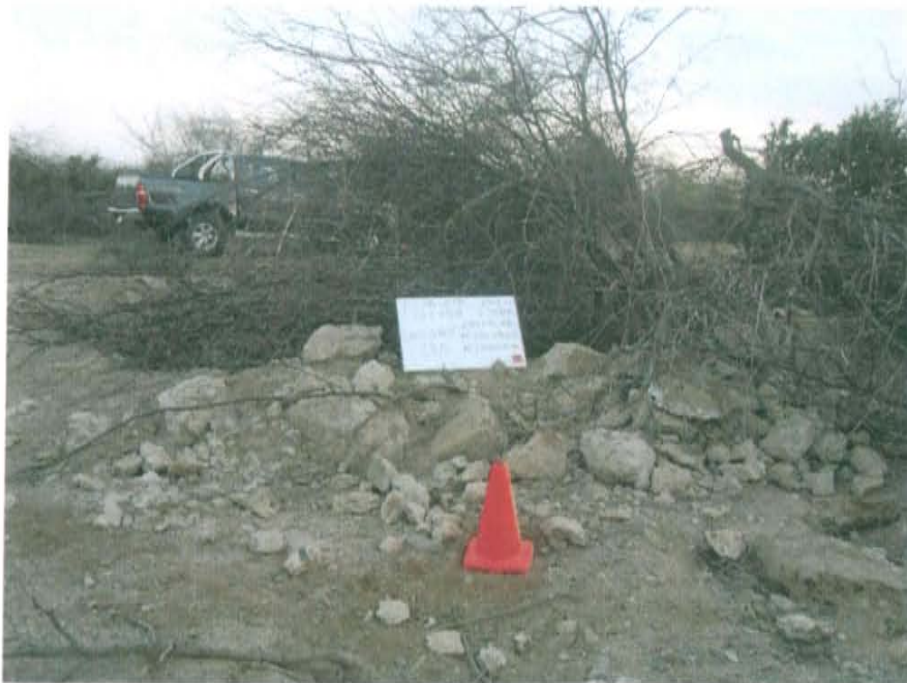
Fotografía N° 2. Vista lateral donde se aprecia suelo impregnado con hidrocarburos y restos de concreto en el área circundante al pozo.
