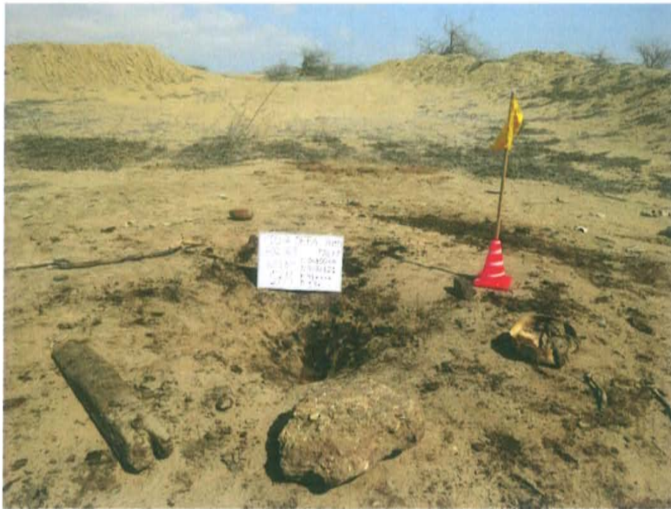
Fotografía N° 1. Pozo inactivo con código PERUPETRO T2677. Se observa casing al nivel de la superficie del suelo.
