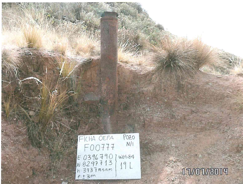
Fotografía N° 1. Pozo inactivo que sobresale una altura aproximada de 2m sobre el nivel de la superficie del suelo erosionado.
