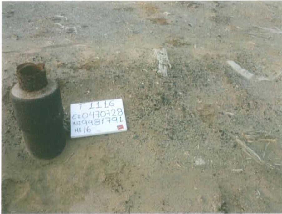
Fotografía N° 1. Pozo inactivo T1116, sin cabezal con casing cementado que sobresale 0,64 m sobre el nivel del terreno, no se encuentra sellado herméticamente.
