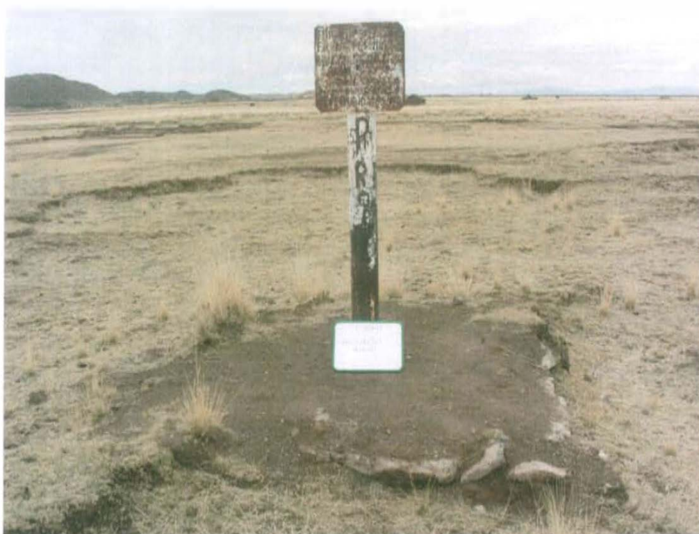
Fotografía N° 1. Pozo con código PERUPETRO YPA_S2_NR_1 en el cual se observa el letrero de abandono, además de observarse plataforma de tierra.
