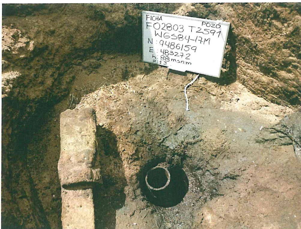
Fotografía N° 1. Identificación del pozo inactivo con código PERUPETRO T2591. Presenta dos casing concéntricos sin elementos de cierre que aseguren su hermetismo por lo que se consideran abiertos y expuestos al ambiente.
