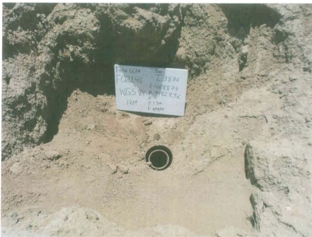
Fotografía N° 1. Se observa dos (02) casing concéntricos que se encuentra abierto al ambiente.
