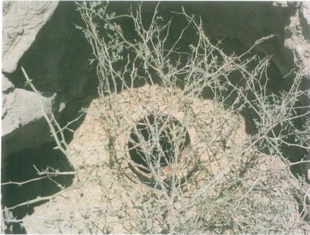
Fotografía N° 1. Identificación del pozo inactivo con código PERUPETRO T2814. Presenta casing abierto al medio ambiente.
