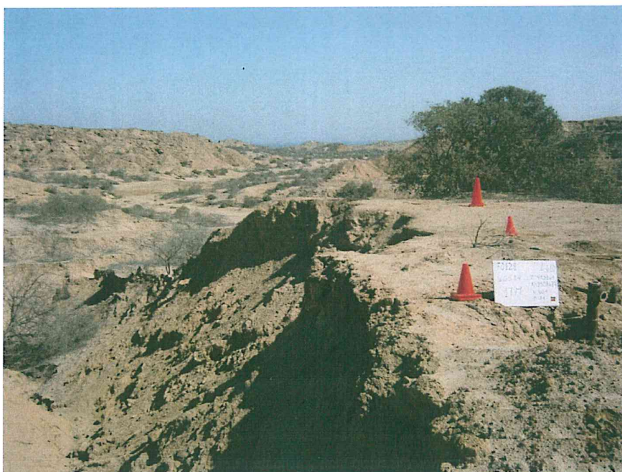
Fotografía N° 1. Vista del estado actual del pozo con código L_610 durante la visita de campo realizada por el personal de evaluación del OEFA.
