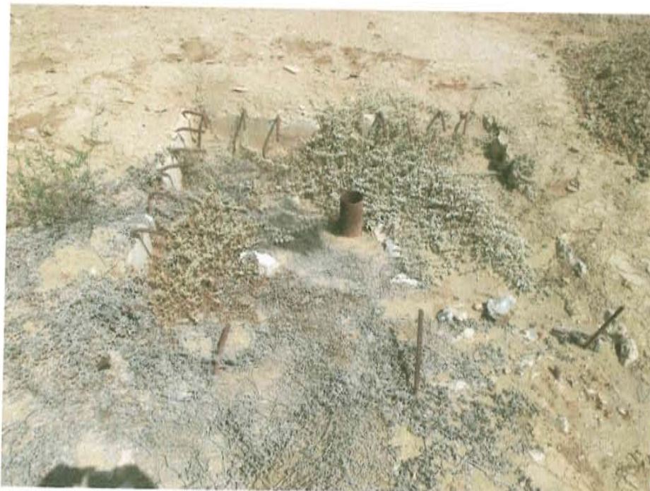
Fotografía N° 2. Vista de la cantina deteriorada de cemento y la vegetación herbácea alrededor del pozo T5292
