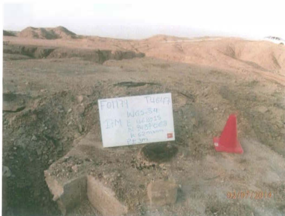
Fotografía N° 1. Pozo inactivo con casing corroído al ras del suelo.
