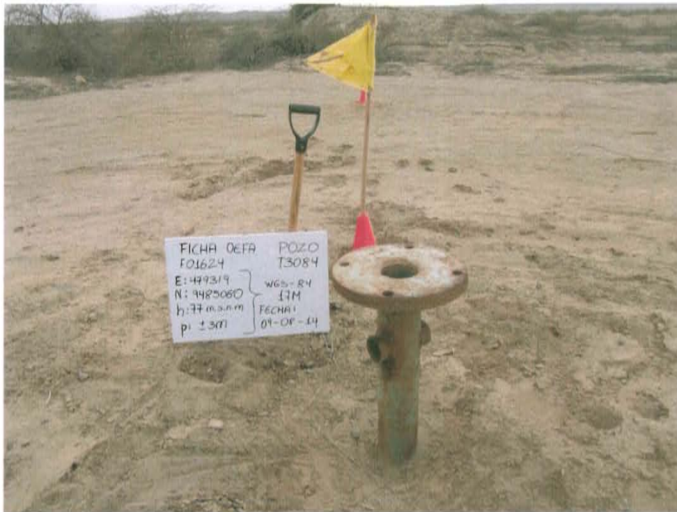
Fotografía N° 1. El Pozo T3084, presenta cabezal compuesto por una brida, unida a un casing de aproximadamente 5,5 pulgadas, sin válvulas que aseguren su hermetismo.
