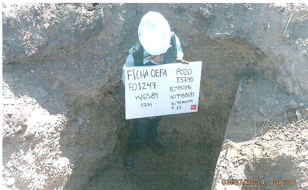
Fotografía N° 1. Vista del pozo petrolero inactivo, se observó hoyo de sección cuadrada dentro del cual está ubicado el pozo y no presenta tubería de revestimiento (casing) a nivel de superficie de suelo.
