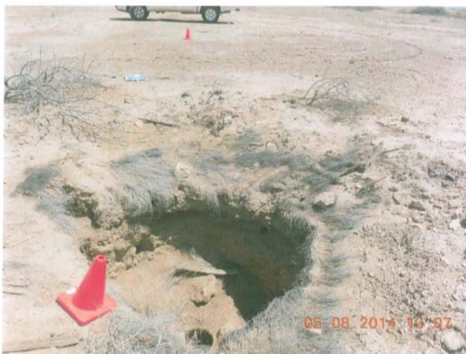
Fotografía N° 2. Pozo T4130 ubicado en interior de un hoyo de sección aproximadamente cuadrada de 2,56 m 2 y 1,1 m de profundidad.
