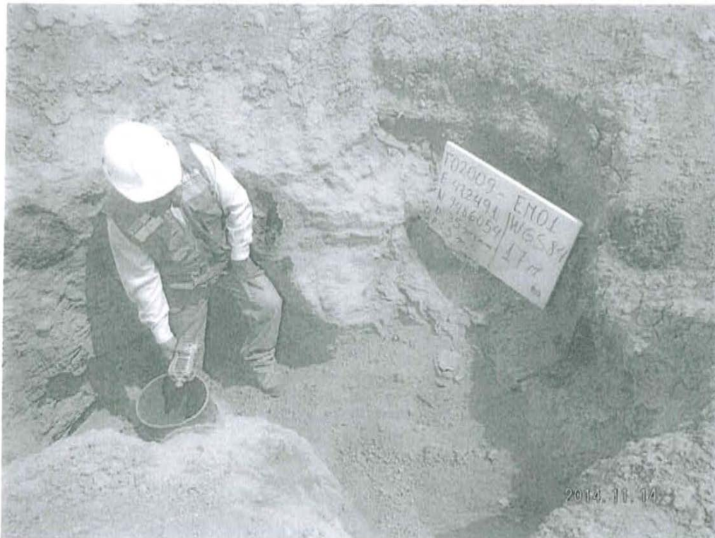
Fotografía N° 1. Medición en el punto F02009-EM01, ubicado en la fuente de emisión en boca del Pozo T2273
