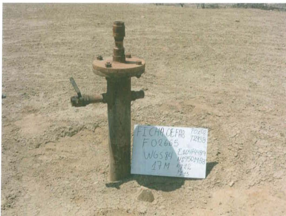
Fotografía N° 1. Pozo inactivo en terreno habilitado tipo terraplén, con acceso vehicular directo. El cabezal del pozo, está compuesto por un brida, un tubo reducción y dos salidas laterales, además de válvulas de cierre en estado de corrosión.
