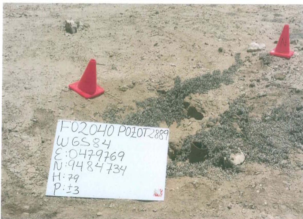
Fotografía N° 1. Pozo inactivo con código PERUPETRO T2889 donde se observa un casing cortado y corroído sobresaliendo una altura aproximada de 0,14 m sobre el nivel del suelo.
