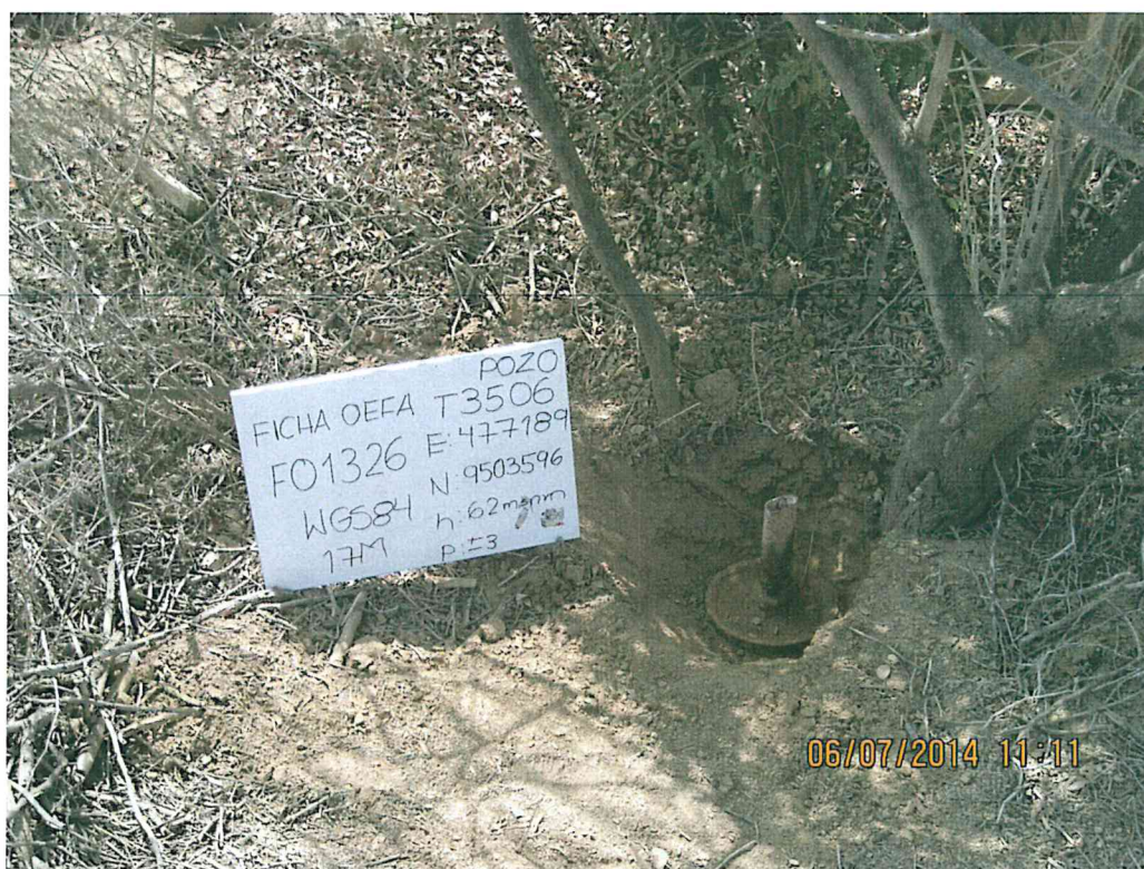
Fotografía N° 1. Se observa casing con reducción de tubería de 2 plg que sobresale 0,25 m del nivel de la superficie de suelo.
