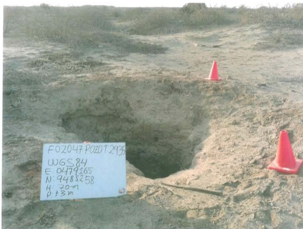
Fotografía N° 1. Pozo inactivo con código PERUPETRO T2935 ubicado en el interior de un hoyo de forma irregular de aproximadamente 2,5 m de profundidad.
