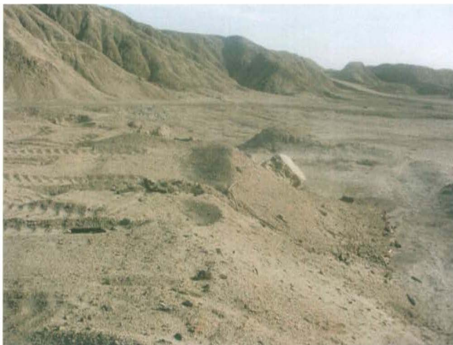
Fotografía N° 3. Terraplén de reciente reconfiguración, fuera del éste se han colocado el material de desbroce, listones de madera ( impregnadas con hidrocarburos) y bloques de concreto de antiguos soportes.
