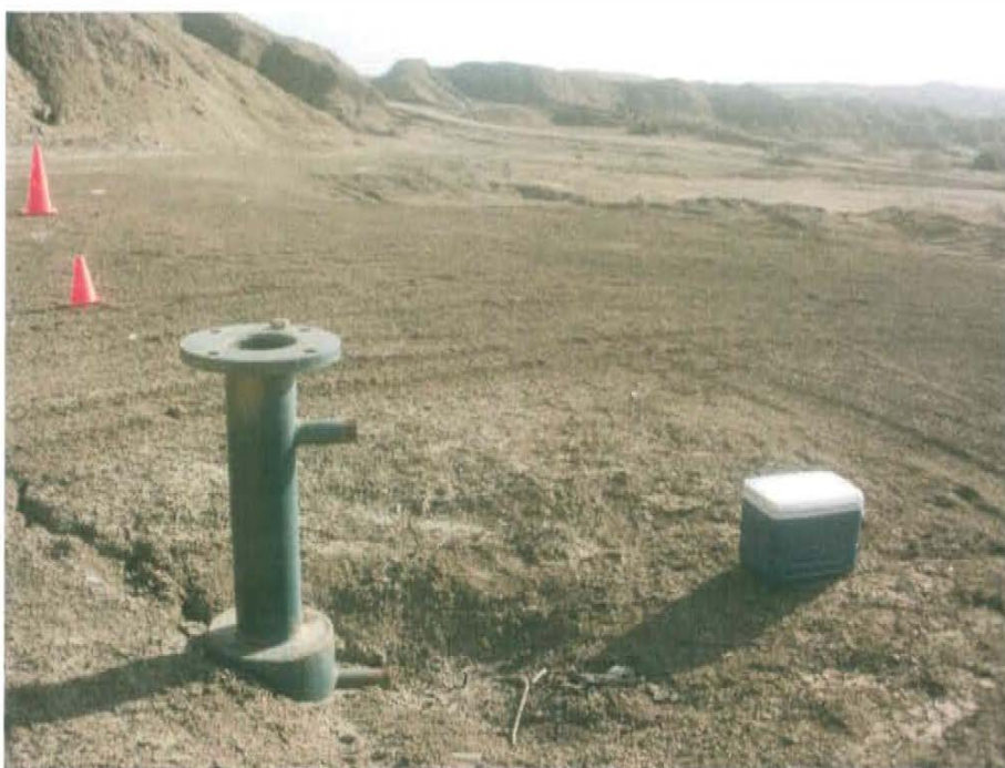
Fotografía N° 1. Pozo L_380 con tubería de revestimiento con brida de 13 pulgadas de diámetro abierto y expuesto 0,9m sobre la base del terraplén.
