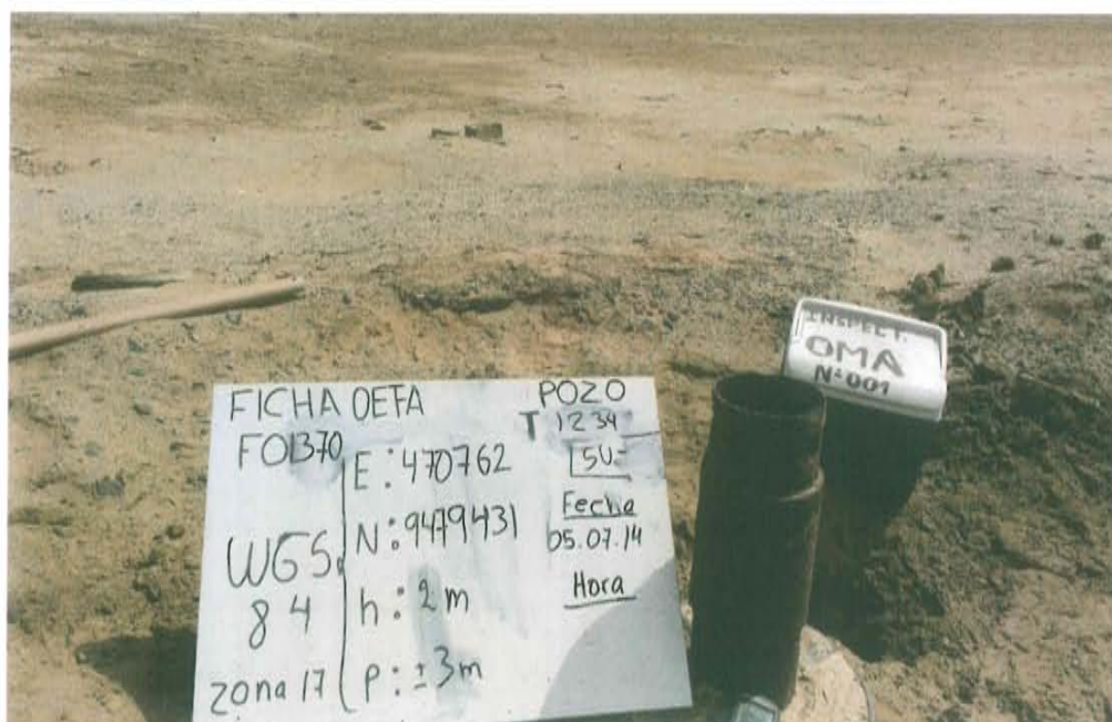
Fotografía N° 1. Ubicación del pozo con código PERUPETRO T1234 en el que se observa el casing corroído con presencia de hidrocarburos en el suelo superficial de los alrededores del pozo.
