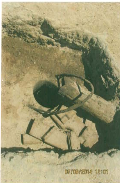
Fotografía N° 2. El pozo presenta casing y tubing abierto sin elementos de cierre en superficie (llaves, válvulas entre otros) que garanticen un cierre hermético del pozo.
