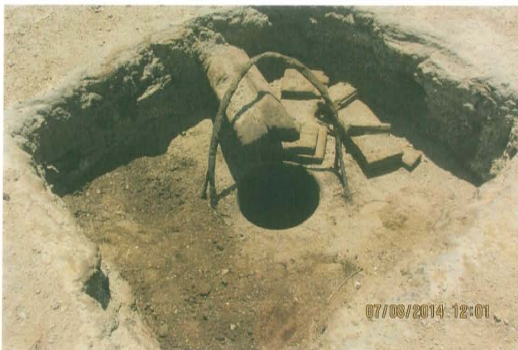
Fotografía N° 1. Se observa pozo inactivo en el interior de una cantina deteriorada, con casing y tubing expuesto al ambiente.
