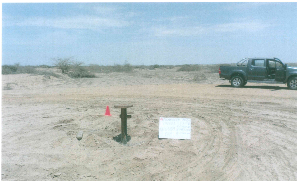
Fotografía N° 2. Vista panorámica del pozo T3148, se observa un terreno habilitado tipo terraplén con acceso vehicular directo al pozo y con un camino demarcado.
