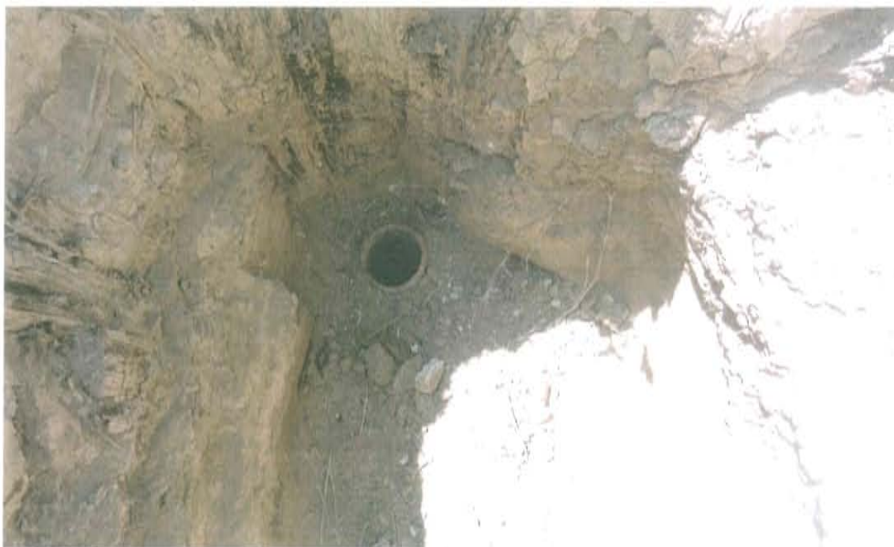
Fotografía N° 1. Vista del Pozo T_329, se observa casing abierto al ras del suelo.
