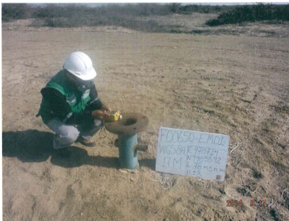
Fotografía N° 4. Medición de emisiones fugitivas en fuente de emisión, boca del pozo.
