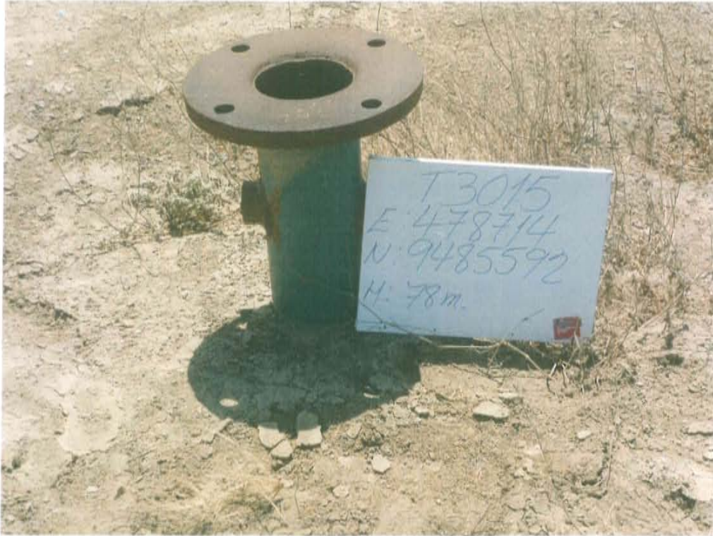
Fotografía N° 1. Pozo inactivo con código PERUPETRO T3015, en terreno habilitado con acceso vehicular directo. El cabezal del pozo está compuesto por una brida unida a un casing de 6 pulgadas de diámetro.
