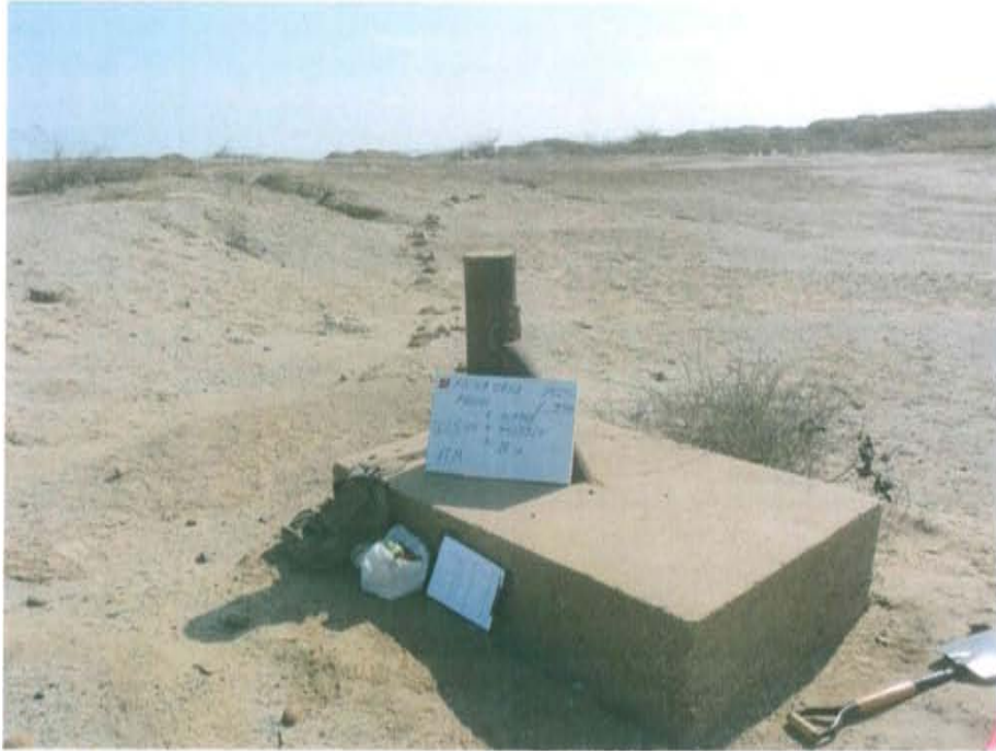
Fotografía N° 1. Pozo L_298, presenta casing con cemento en su interior y rodeado de un bloque de concreto.
