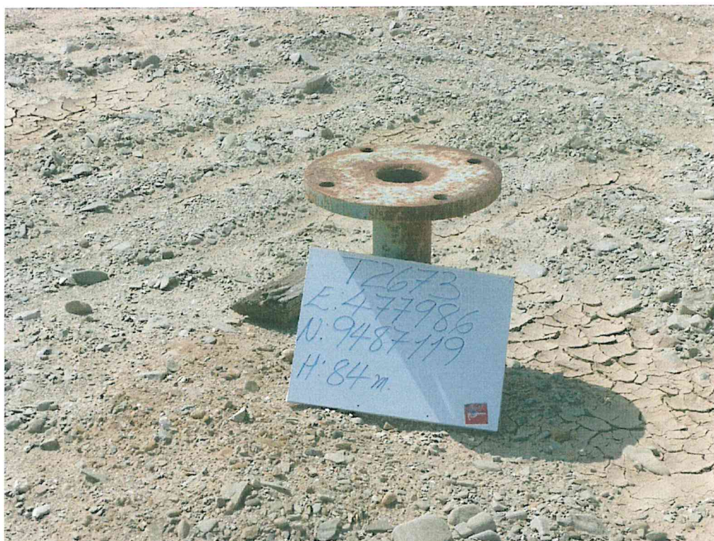
Fotografía N° 1. Pozo inactivo con código PERUPETRO T2673 que encuentra abierto y expuesto al ambiente.
