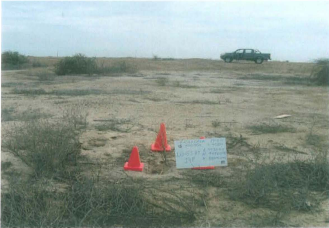
Fotografía N° 01.- Pozo con código PERUPETRO T4080 y con código Ficha OEFA F00904, se observa que el casing no cuenta con cabezal ni válvula de cierre por lo que se encuentra expuesto al ambiente.
