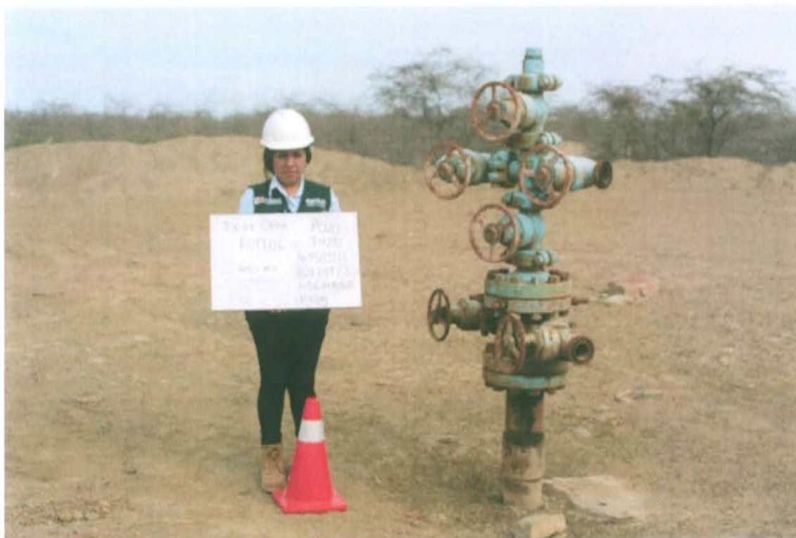
Fotografía N° 1. Identificación del pozo inactivo con código PERUPETRO T4212. Presenta cabezal del Pozo (árbol de navidad) abierto y corroído.
