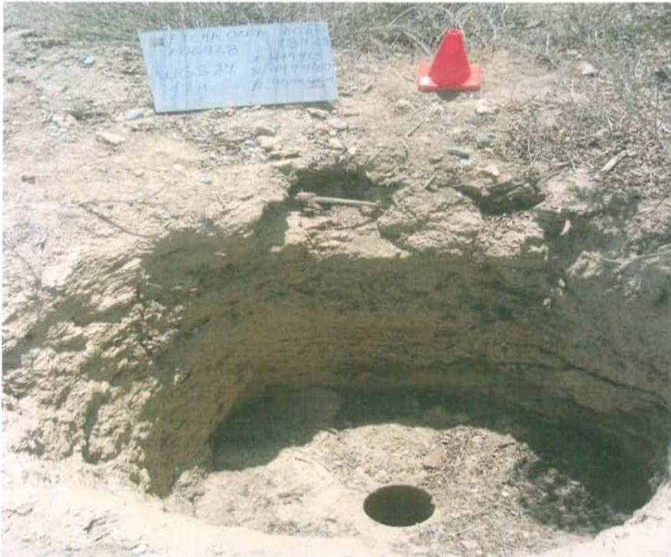
Fotografía N° 1. Pozo con código Ficha OEFA F00928 y con código PERUPETRO T3425, se observa el casing del pozo dentro de un hoyo a nivel de la superficie del suelo que no presenta cabezal o alguna válvula de cierre por lo que se encuentra expuesto al ambiente.
