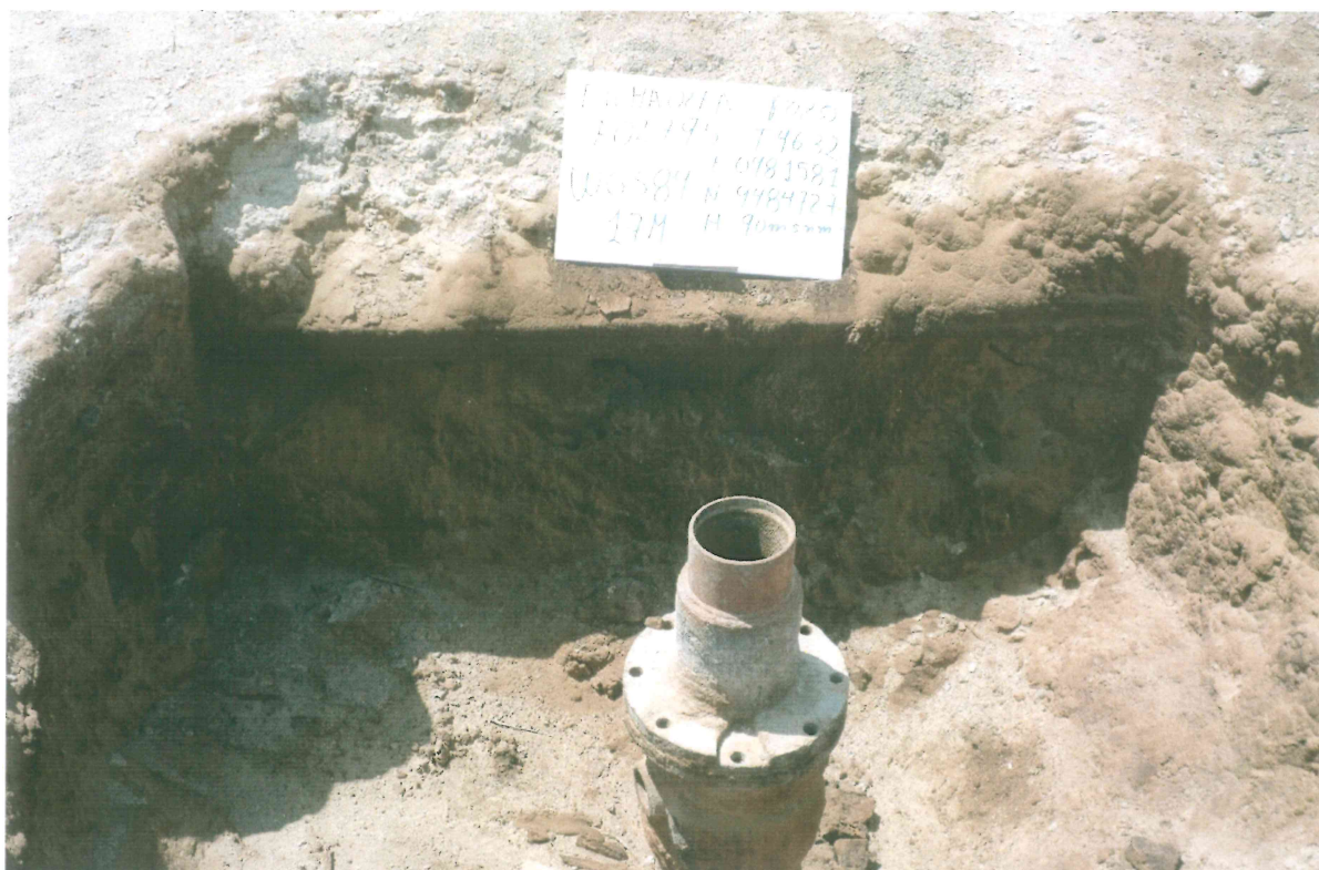
Fotografía N° 1. Pozo con código PERUPETRO T4632 y código Ficha OEFA F02795, se observa el casing con dos tuberías laterales, y unido a un cabezal compuesto por una brida reductora y un arreglo de tuberías que se encuentran abiertos al ambiente.
