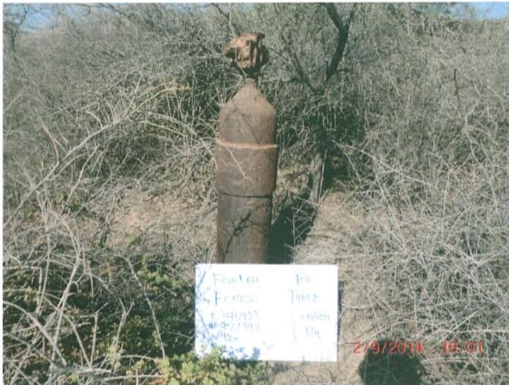
Fotografía N° 1. Identificación del pozo inactivo con código PERUPETRO T4808. Presenta casing con válvula corroída.
