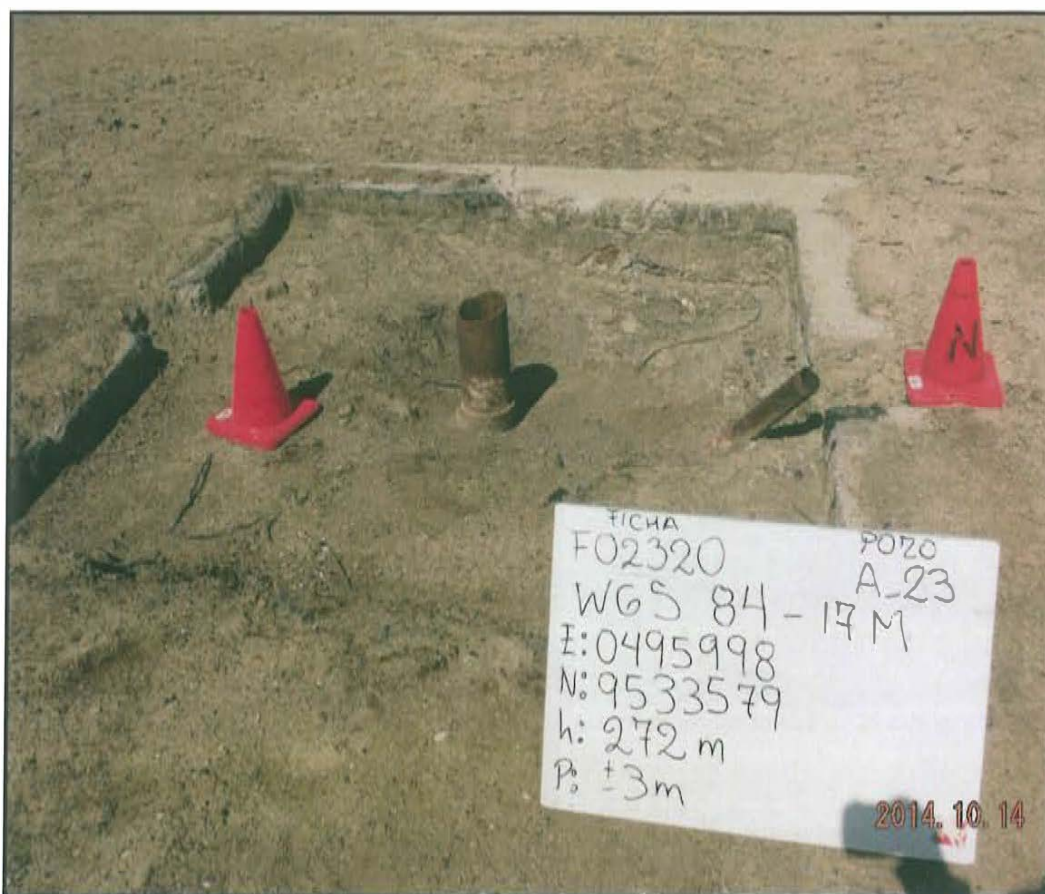
Fotografía N° 1. Pozo A__23, se visualiza caising corroído de 5 plg, cortado a los 0,3 m de altura y tubo inclinado de 2 plg y 0,4 m de longitud, dentro de cantina rellena de tierra.
