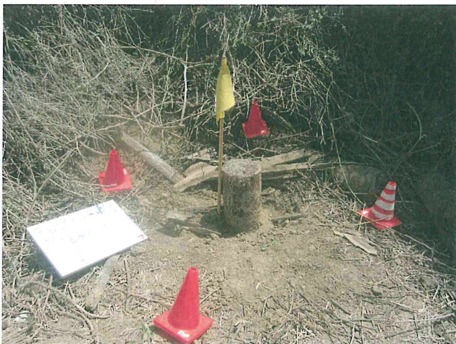
Fotografía N° 2. Se observa que el pozo se encuentra cementado, sin embargo no se observa la varilla de de acero de dos (2) metros de altura sobre el nivel de la superficie conteniendo el número del pozo, tampoco se encuentra cercado.
