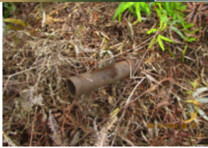
Presencia de otro residuo metálico (retazo de tubo) oxidado y deteriorado cubierto por vegetación herbazal (helechos), ubicado dentro del sitio por el punto de sondeo S0385-SU-005.
