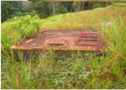
Vista del sitio S0385 ubicado en primer fondo al tanque sumidero (Plataforma D), cubierto por pastos y en condición no operativa;
