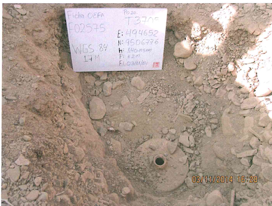
Fotografía N° 1. Se observa la ubicación del pozo inactivo, el cual se encuentra abierto, sin elementos de cierre en superficie.
