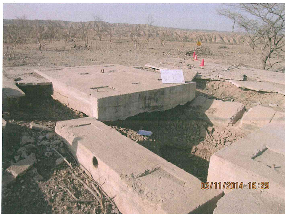
Fotografía N° 2. Se observa la excavación en donde se localizó el pozo inactivo entre plataformas fraccionadas de concreto.
