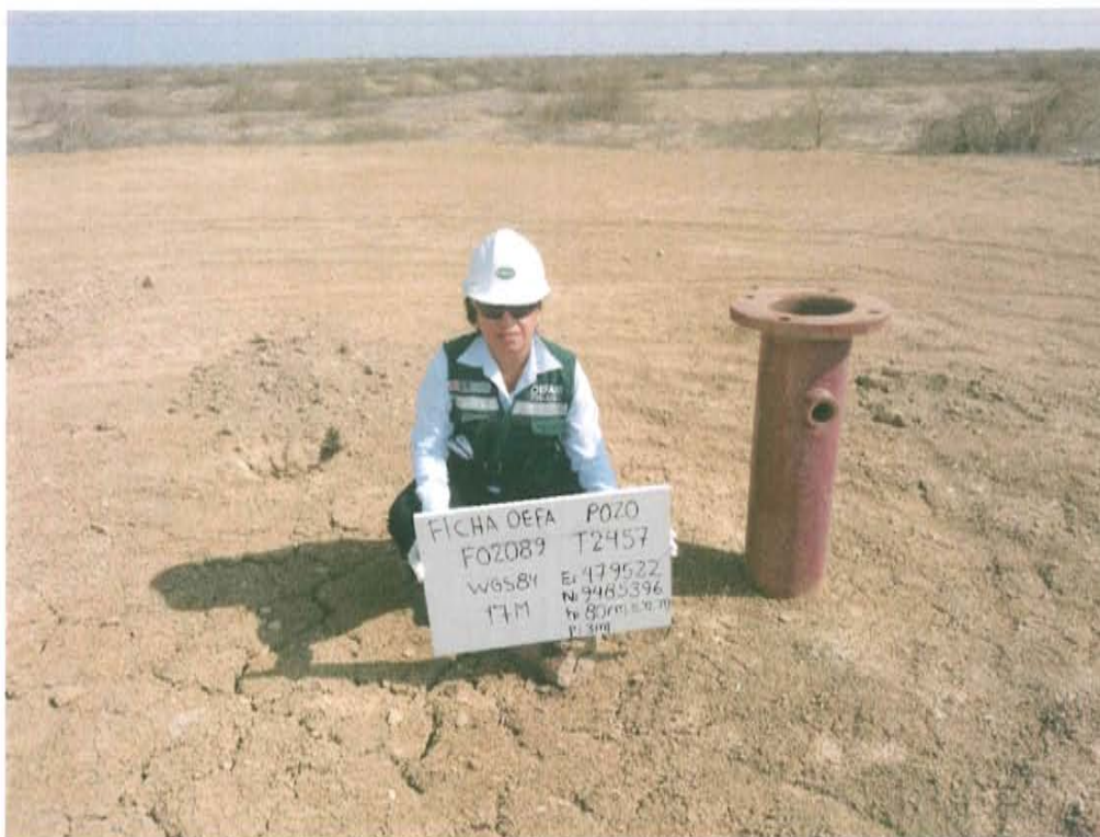
Fotografía N° 1. Identificación del pozo inactivo con código PERUPETRO T2457. Presenta casing con tapa de brida adaptadora con salidas laterales y expuestas a la intemperie.
