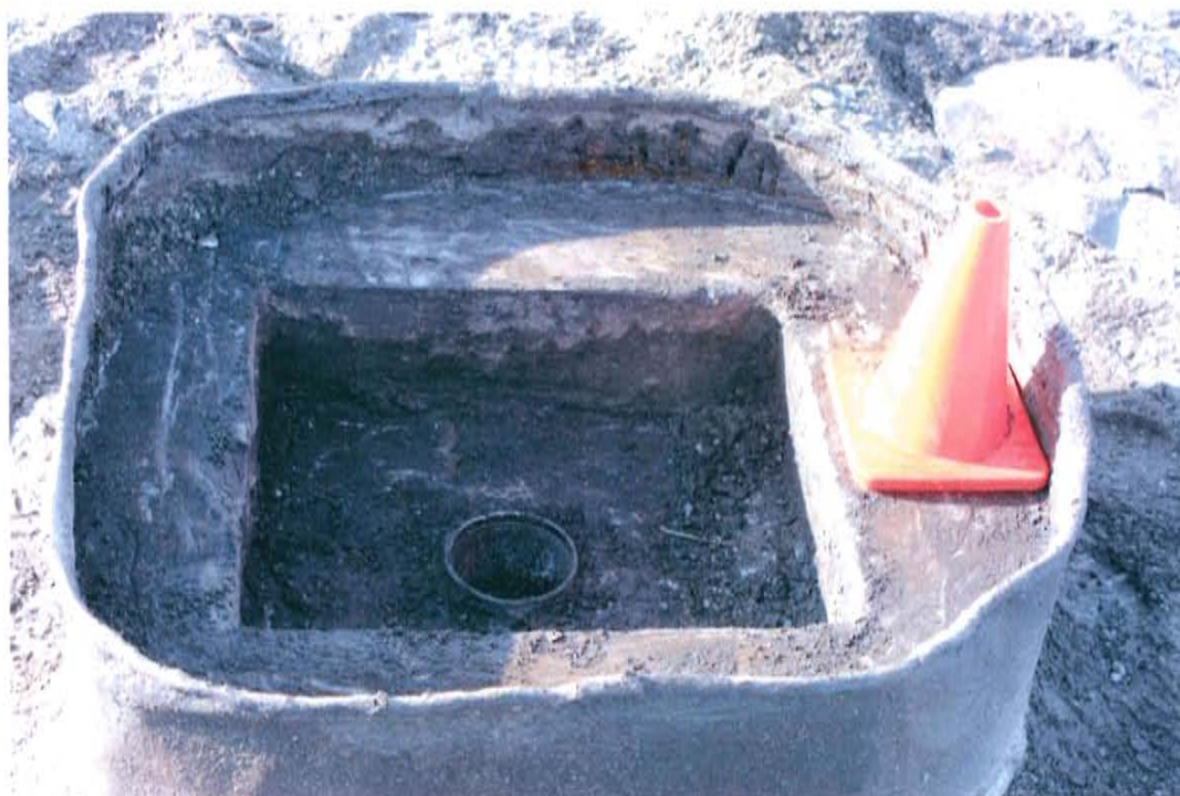
Fotografía N° 3. Se observa casing de 6 plg de diámetro ubicado en el interior de un hoyo de concreto de sección rectangular de 0,56 m x 0,64 m x 0,18 m de profundidad.
