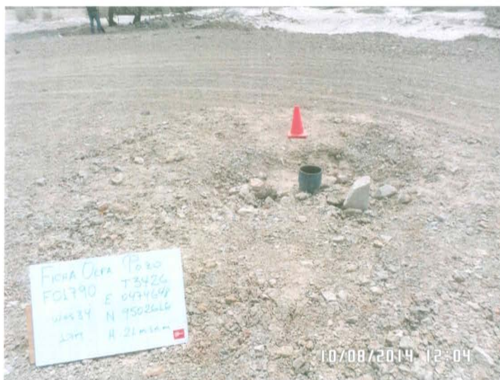
Fotografía N° 1. Identificación del pozo inactivo con código PERUPETRO T3426. Presenta casing sin válvulas que aseguren su hermetismo.
