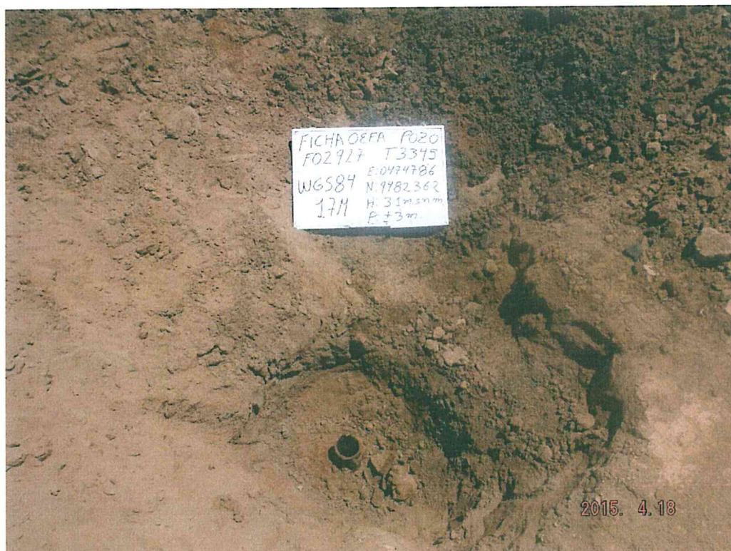
Fotografía N° 2. Se aprecia que el pozo T3345 no presenta elementos que garanticen el cierre hermético del pozo, asimismo se aprecia presencia de hidrocarburo en el suelo.
