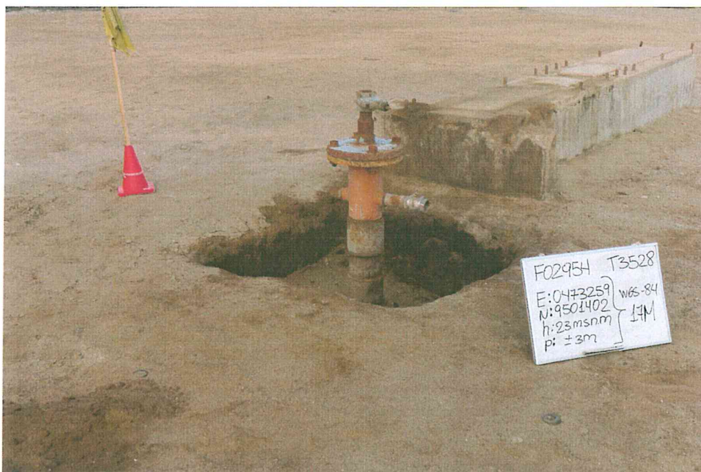
Fotografía N° 2. Se observa que el pozo presenta un evidente estado de deterioro y corrosión además de observa coloración característica a hidrocarburos y adyacente al pozo se encuentra una base de concreto.
