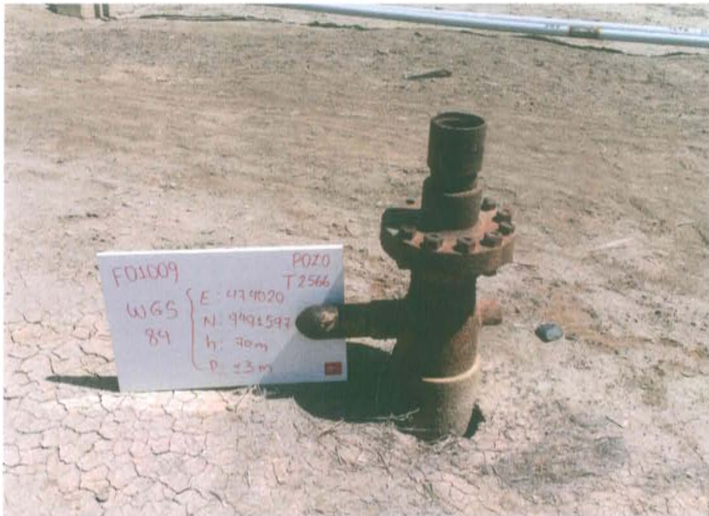
Fotografía N° 1. Identificación del pozo inactivo con código PERUPETRO T2566. Presenta casing oxidado sin evidencia de cantina.
