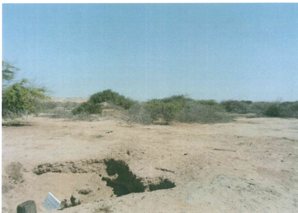
Fotografía N° 4. se observa las estructuras deterioradas con un grado de peligrosidad alta debido a no encontrarse cercado o señalizado
