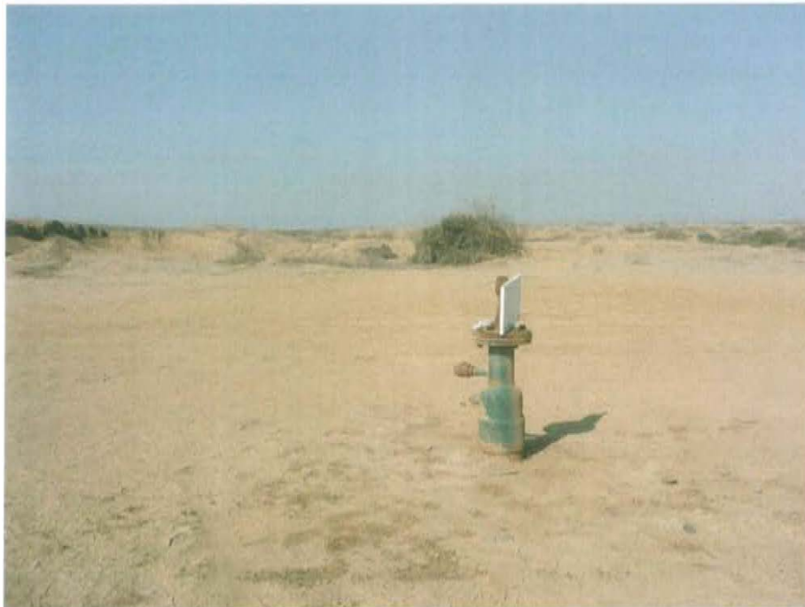
Fotografía N° 2. Vista panorámica de la ubicación del pozo T2296, área habilitada tipo terraplén, sin señales de prevención..
